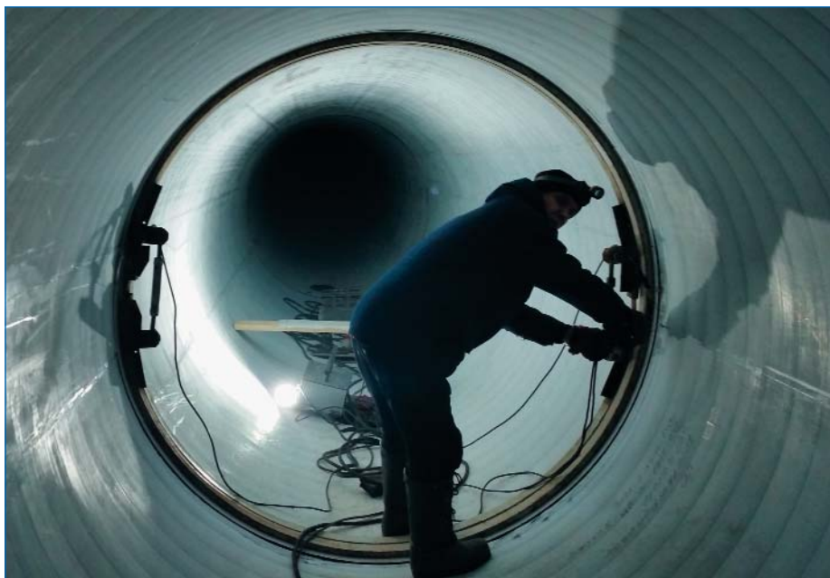
■ Рис. 3. Соединение отводов КОРСИС ПЛЮС во вскрытом канале
