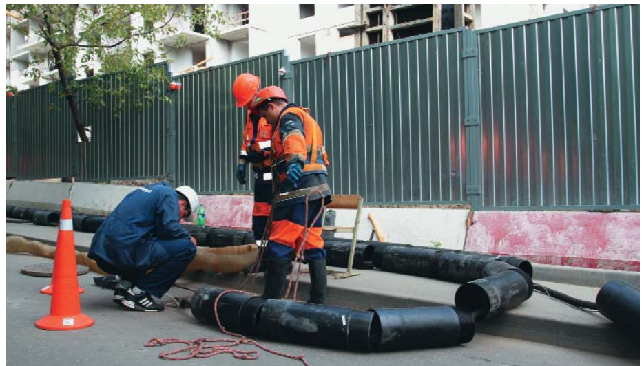
Подготовка к монтажу литых модулей
