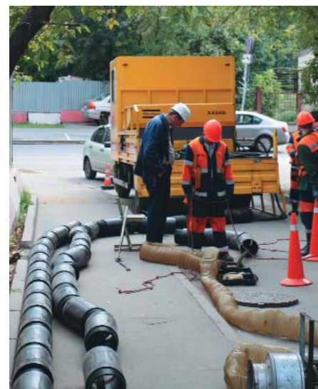
Монтаж литых резьбовых модулей
